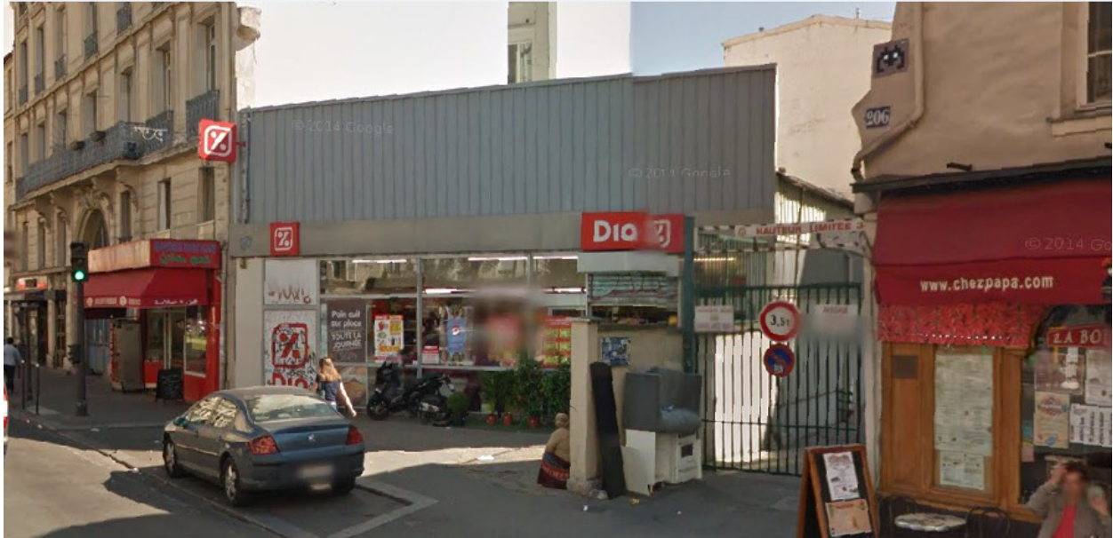
Rue du Faubourg Saint-Martin, Paris
